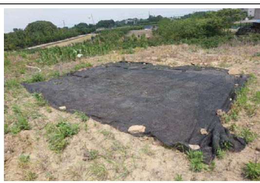
弃土区裸露地表临时覆盖
