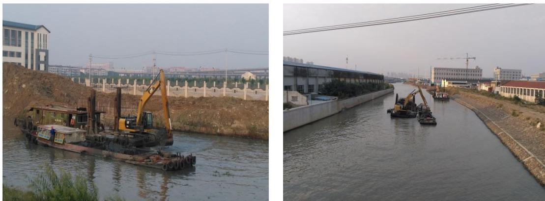
图 4.2-1 采菱港河道疏浚挖泥船施工
